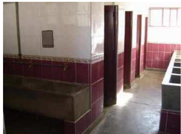
Renovierter Wasch- und Duschräum im Hogar Campesino in Akasio
