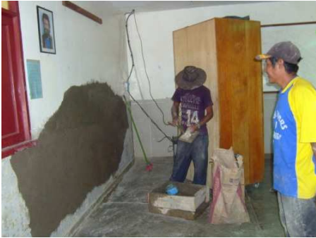
Verputzen nach leichteren Erdbeben
