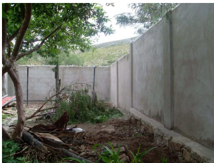
Neuaufbau einer eingestürzten Mauer im Schulgarten
