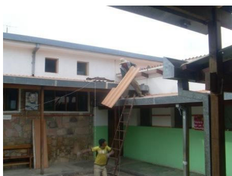
Dacherneuerung im Wohnheim in Toro Toro
