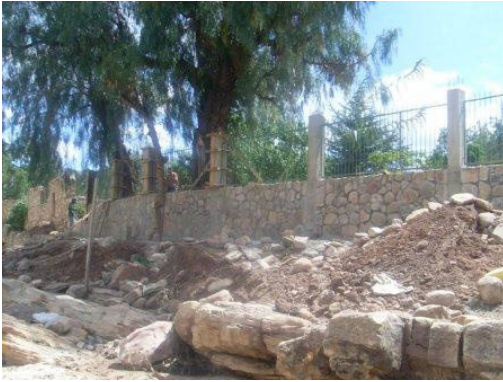
Ein weiteres Mal (allerdings an einer anderen Stelle als im Vorjahr): Erneuerung der Mauer am Schulgarten des Wohnheims in Toro Toro
