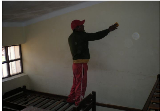
Vorbereitung der Wände in einem Schlafraum für einen neuen Anstrich
