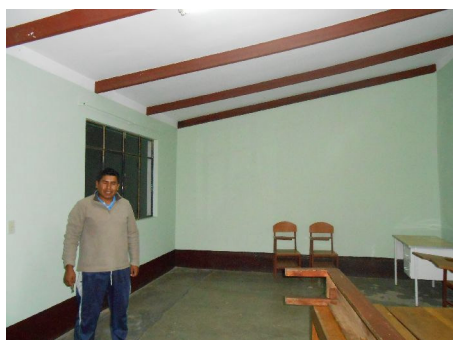
Renovierung zusätzlicher Räume in Karipuyo
