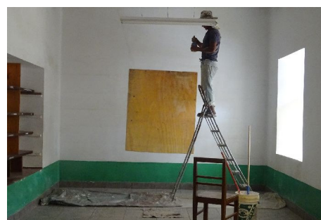
Renovierung der Bibliothek in San Pedro
