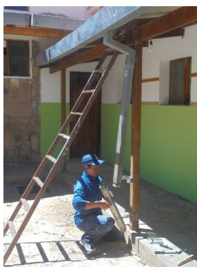
Erneuerung von Dachrinnen und Abwasserrohren in Torotoro
