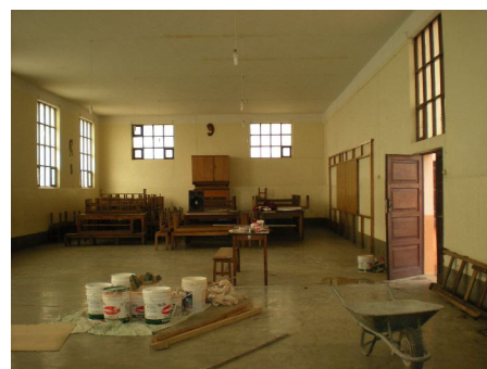
Renovierung des Speisesaals in Sakaka
